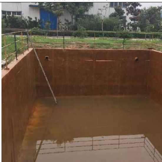
事故池玻璃钢防腐防渗
