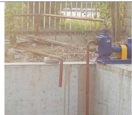
初期雨水收集池
