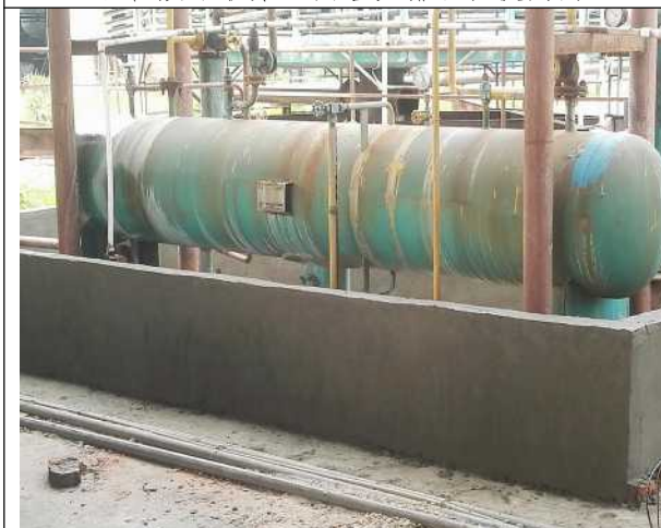
氨罐区围堰
