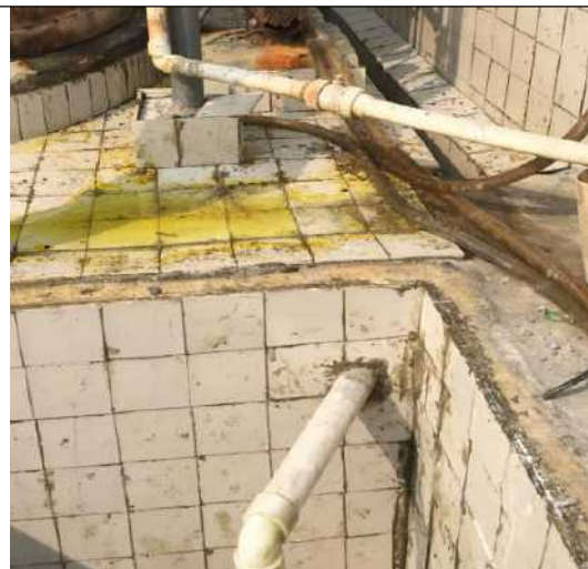
酸吸收区耐酸砖防腐防渗
