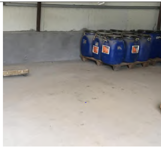
危废仓库内防渗
